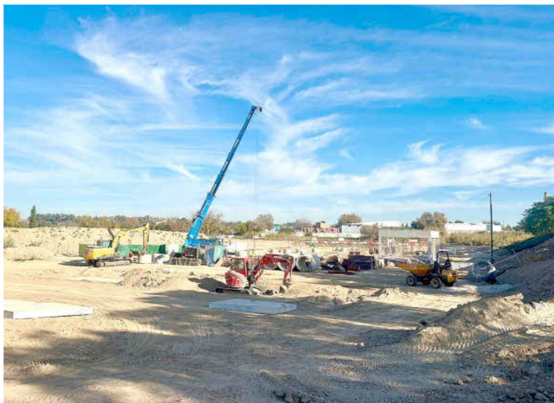
Zonas de obras para construir el tanque de tormentas soterrado de Alcantarilla.
