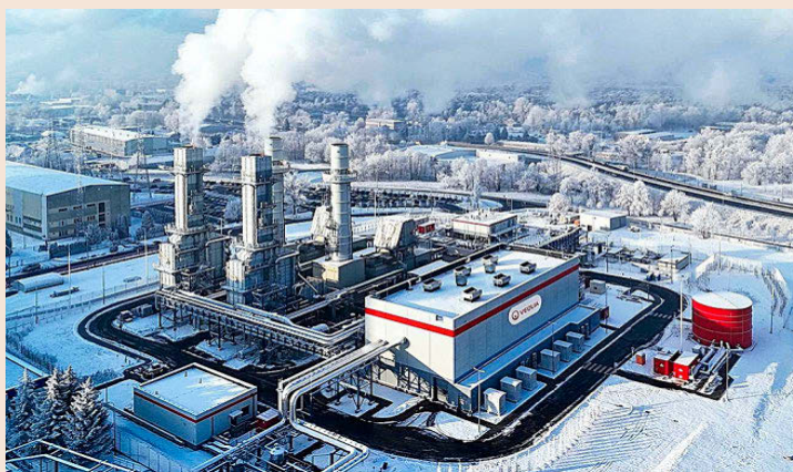
Planta de cogeneración de Veolia en Poznan (Polonia).
